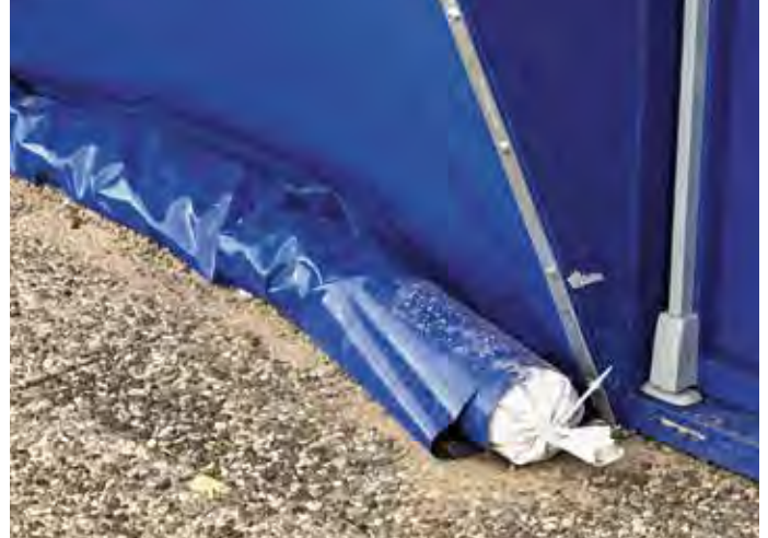
Fußpunktdetail der Traglufthalle neben einer Notausgangstür
