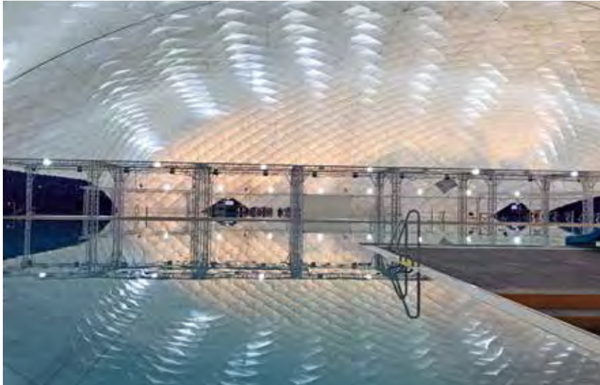
Alutraversen sichern die Fluchtwege auch bei Druckabfall in der Halle
